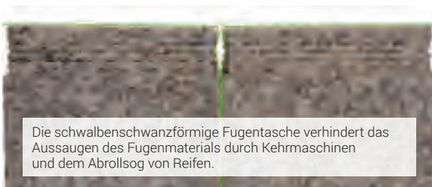
Die schwalbenschwanzförmige Fugentasche verhindert das Ausaugen des Fugenmaterials durch Kehrmaschinen und dem Abrollsoß von Reifen.
